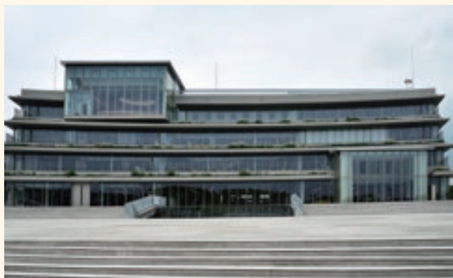
志木市役所新庁舎
