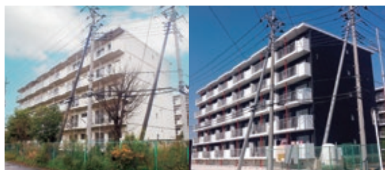
再生前の建物外観(左)、「ReBreath」での再生(右)
