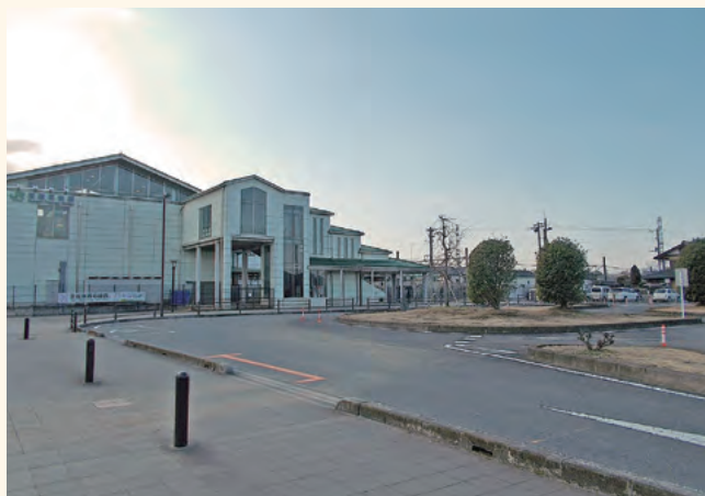
土地地区画整理事業が進む武蔵高萩駅北地区
