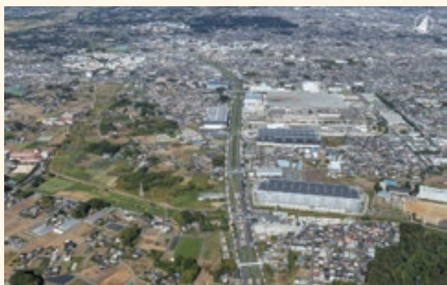
物流拠点の整備が続く上尾道路（堤崎付近） 出典：関東地方整備局ウェブサイト ( https://www.ktr.mlit.go.jp/oomiya/oomiya00118.html )
