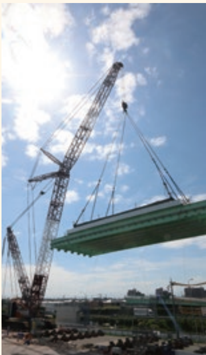
白岡宮代線の橋桁架設工事
